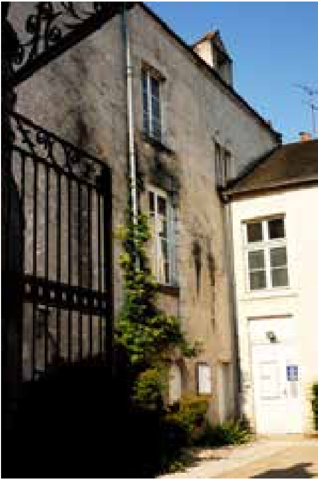
Fig.19 . Vue de la façade nord sur cour de l'hôtel dit « de la Salle » (cl. JM 2012)
