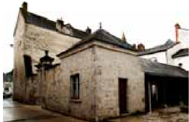
Fig.21. Vue de l'hôtel de la Salle prise depuis le nord-est. Noter le petit bâtiment avec sa porte médiévale (cl. J 2013)
