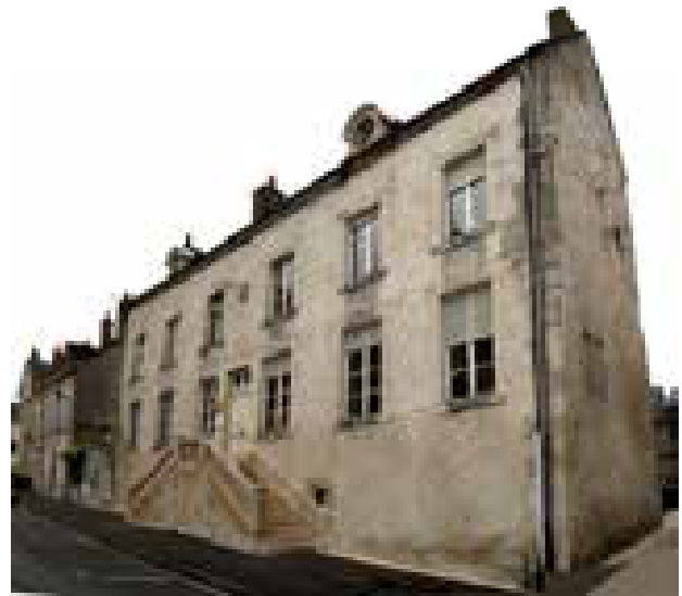
Fig.20. Vue de l'Hôtel de la Salle prise depuis le sud-est en 2013. Noter les ouvertures médiévales dans le pignon (cl. JM)
