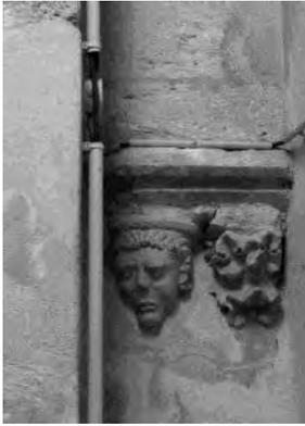
Fig.37. Vue de la retombée de l'arc allongeant la chapelle S1, prise depuis le sud. À gauche, mur de 1864 fermant la chapelle (cl. J. Mesqui 2013)
