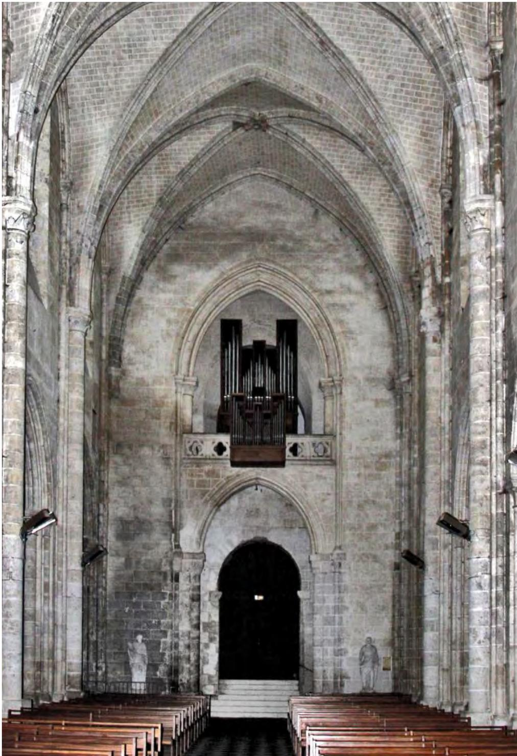
Fig.5. Vue du mur-diaphragme à arcades de 1864, pris depuis l'est. On note, à l'intérieur de l'arcade basse, la porte en plein cintre percée dans la face est du clocher-porche, en retrait du mur-diaphragme. Au-dessus, la tribune et le buffet d'orgue restauré par Haerpfer-Erman en 1971, installé dans une grande arcade percée dans la face est du clocher (cl. J.Mesqui 2013)
