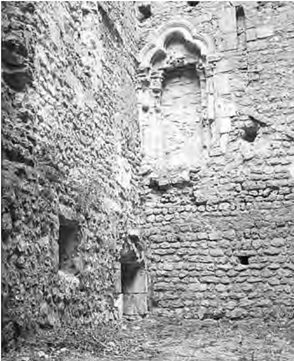
Fig.25. L'angle nord-ouest de la tour au début du XX<sup>e</sup> siècle (cl. Lefèvre-Pontalis). La tour est ici dans l'état qu'elle conserva jusqu'en 2000, avec le niveau bas de soubassement comblé. Les deux ouvertures visibles sur la gauche sont la niche et la fente de jour du niveau haut de soubassement. Au-dessus, la porte monumentale donnant accès au clocher, à hauteur du premier étage. Voir aussi le solin du toit en appentis qui représente un état XIX<sup>e</sup> siècle.
