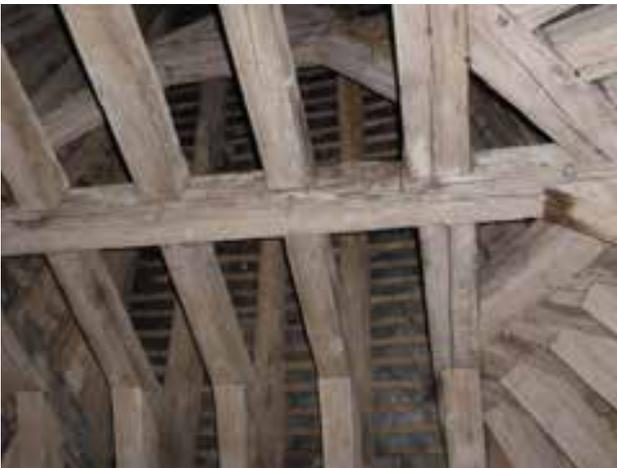
*Fig.159: Détail de l'enrayure haute de la charpente de la tour de Brilhac, avec les entrails retroussés des fermes assemblés dans les faces latérales des sous-faîtières (cl. Chr. Perrault)*
