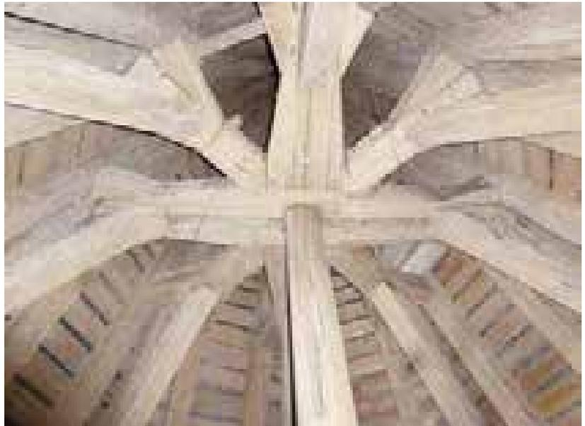
*Fig.152: Enrayure supérieure de la charpente de la tourelle, à entrails retroussés moisés (cl. Chr. Perrault).*
