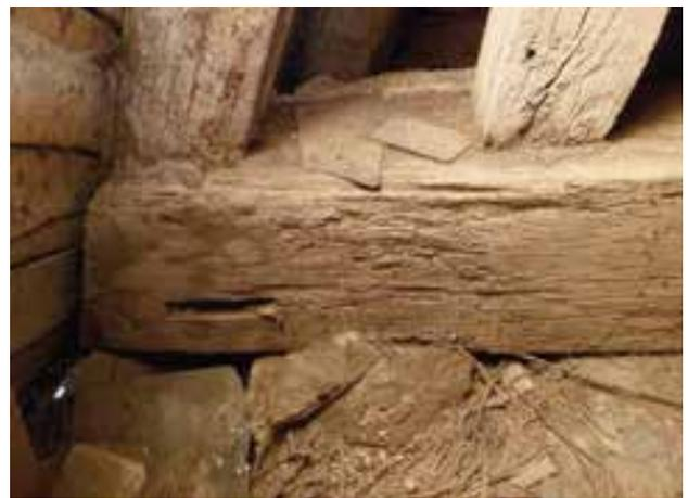
*Fig.160: Mortaise à l'extrémité d'un entrail d'une ferme principale, destinée à recevoir le tenon d'une entretoise (cl. Chr. Perrault)*
