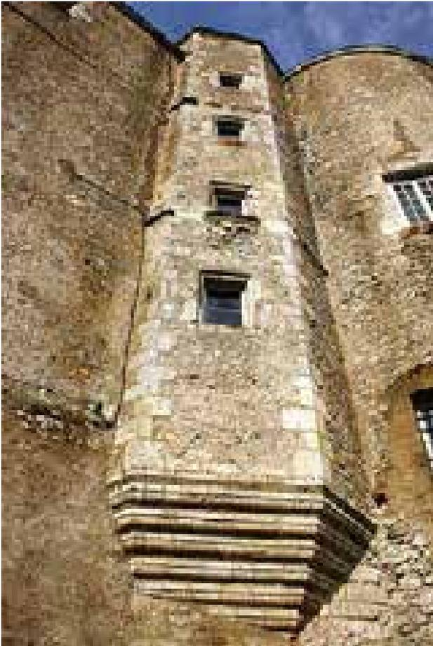
Fig.52: Vue en contre-plongée de la tour d'escalier en vis (cl. J.Mesqui 2011)
