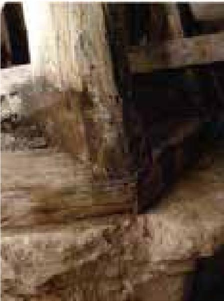
*Fig.151: Dos d'un chevron et d'un blochet, à deux faces, de la charpente de la tourelle d'escalier (cl. Chr. Perrault).*
