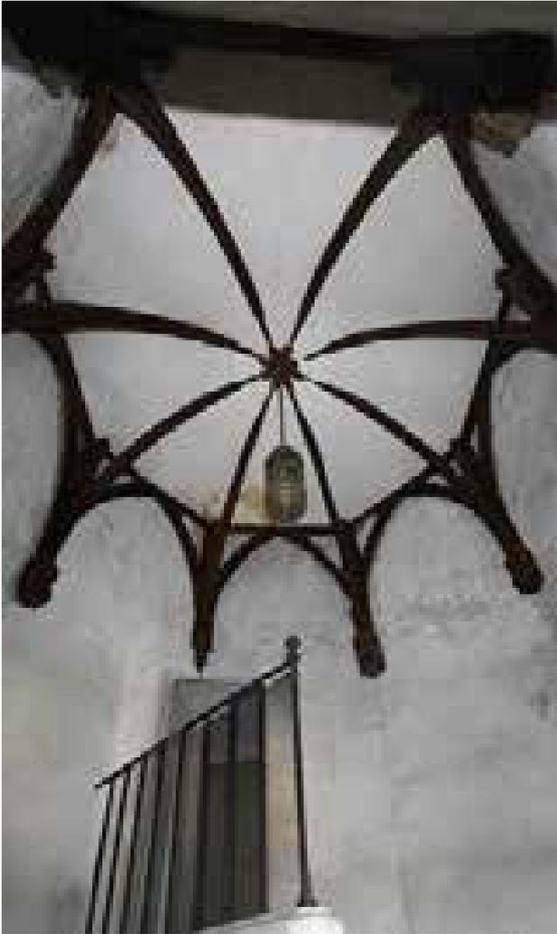
Fig.57: La voûte en bois et plâtre de la grande vis, et la porte du deuxième étage de la tour (cl. J.Mesqui 2013)
