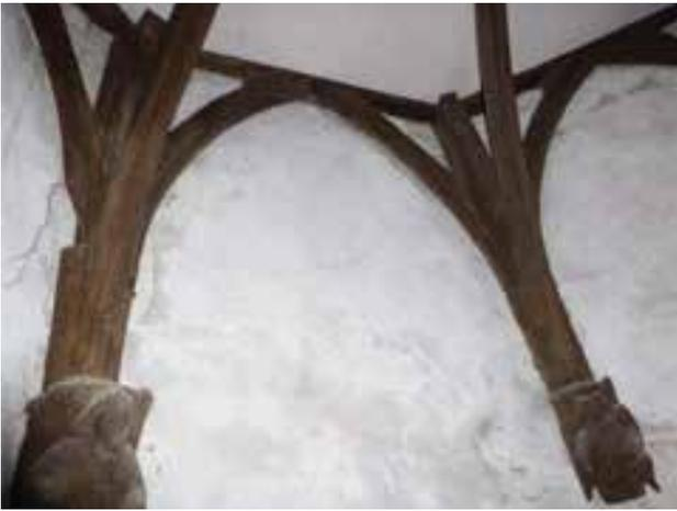
*Fig.157: Détail de la « voûte », avec les arcs formerets et les différentes pièces moulurées (cl. Chr. Perrault)*
