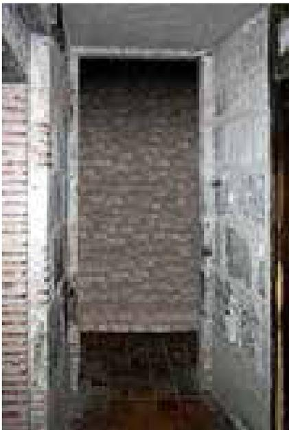
*Fig.72: Vue intérieure prise depuis le sud, de la porte nord du pavillon à contreforts, donnant sur le couloir arrière. Noter le surbassement en briques des piédroits (cl. J.Mesqui 2011)*
