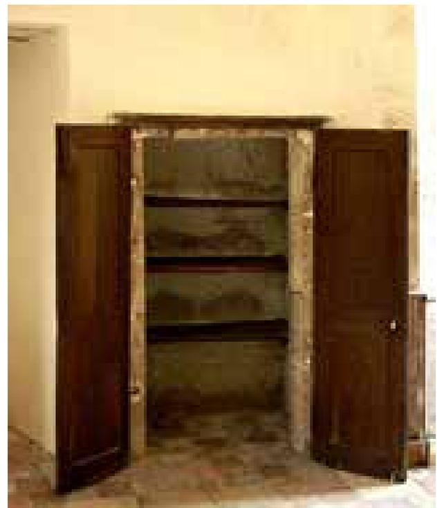
*Fig.27: Ancienne porte au rez-de-chaussée de la tour ouest, transformée en placard. Cette porte donnait peut-être sur un escalier (cl. J.Mesqui 2013)*
