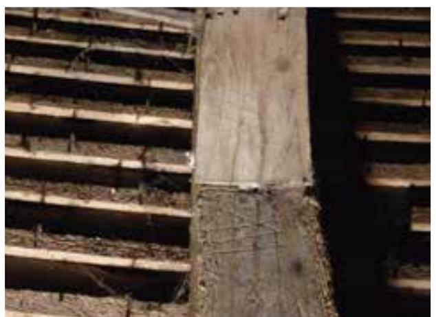
*Fig.162: Marque XVI (16) sur la face inférieure d'un chevron et d'un aisselier d'une ferme de la charpente de la tour (cl. Chr. Perrault)*
