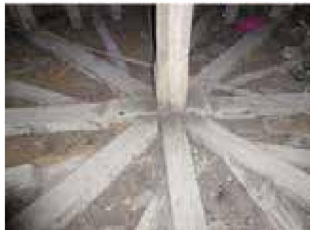
Fig.150: Enrayure inférieure de la charpente de la tourelle d'escalier (cl. Chr. Perrault).
