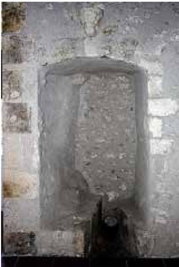
Fig.90: Vue du conduit du lavoir, ménagé dans un ancien ébrasement d'archère. Noter au-dessus de la niche creusée une console médiévale probablement importée (cl. J.Mesqui 2011)
