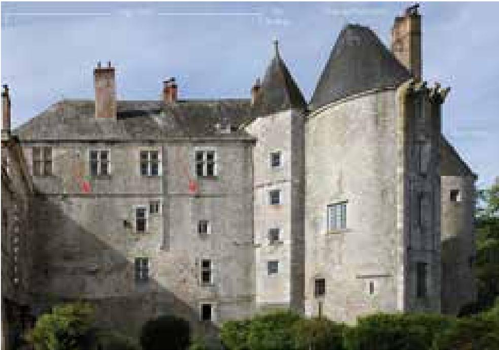
Fig.42: Vue de la façade nord du château, prise depuis l'église au nord. Les flèches rouges marquent l'emplacement de la corniche du logis nord dans son élévation primitive, avant la surélévation due aux Brillhac. À gauche, la chapelle XVIII<sup>e</sup> siècle. (cl. J. Mesqui 2013).
