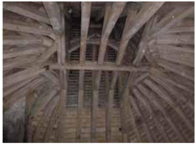
*Fig.158: Enrayure supérieure de la charpente de la tour de Brilhac (cl. Chr. Perrault)*
