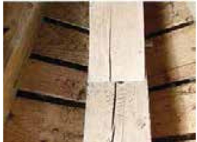
*Fig.154: Marque VIII (8) sur la face inférieure d'un chevron et d'un aisselier d'une ferme de la charpente de la tourelle (cl. Chr. Perrault)*
