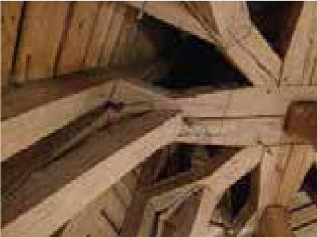
*Fig.153: Détail d'un entrail retroussé moisé de la charpente de la tourelle (cl. Chr. Perrault)*
